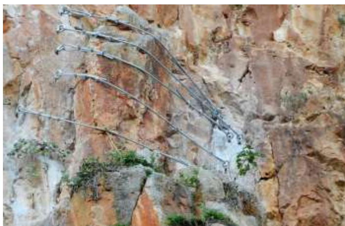
Figura 8: Estabilização individual de bloco de pequena dimensão
