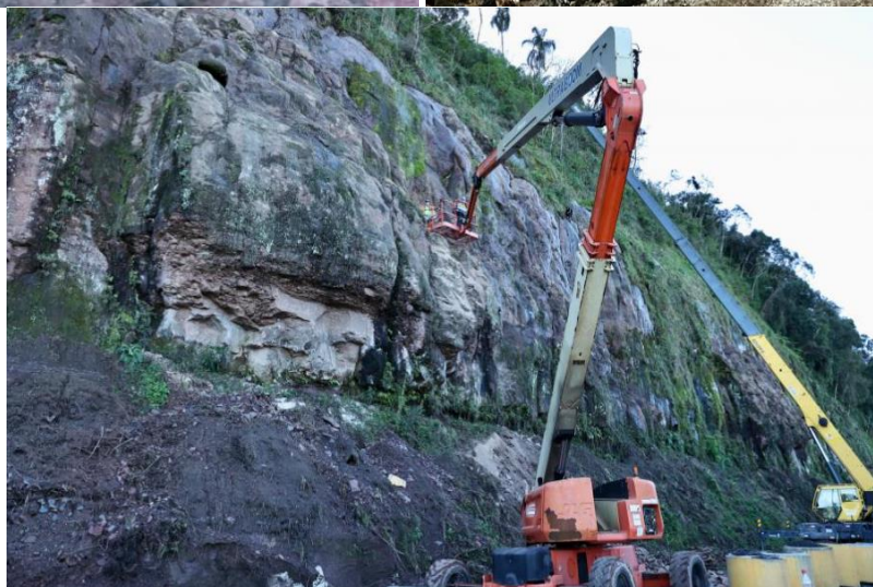
Figura 4 – PN-01 - Bate-choco, limpeza de talude rochoso e remoção de vegetação em alturas de até 4 metros
